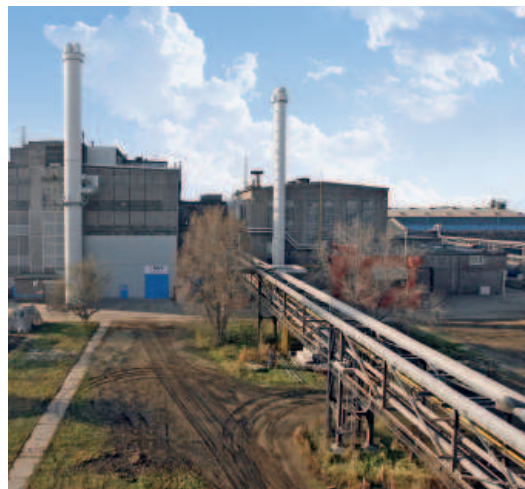
Der Industriepark Ludwigshafen ist ein Beispiel für eine moderne Energiepartnerschaft
